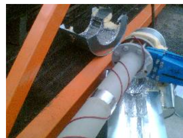
Topný kabel na potrubí s asfaltem před montáží tepelné izolace
