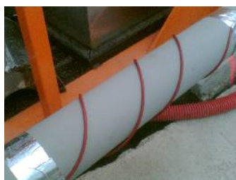
Instalace topného kabelu na potrubí s asfaltem
